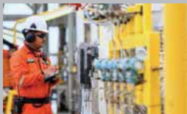
Proyecto refinería Barrancabermeja. Colombia Refinery Barrancabermeja Colombia project
